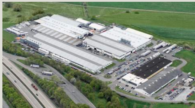
Sede centrale UNILUX a Salmtal
