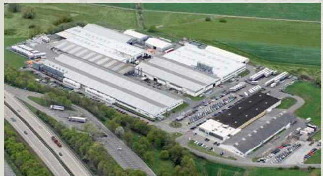
Sede centrale UNILUX a Salmtal
