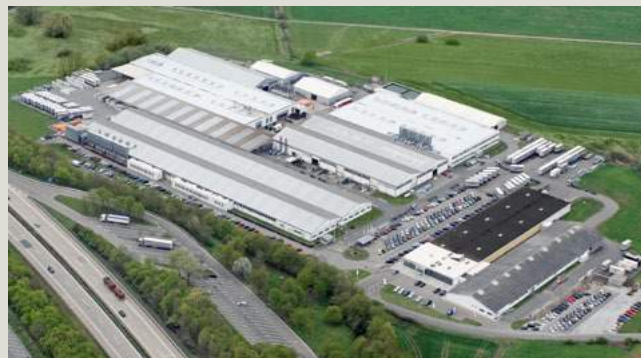
Sede centrale UNILUX a Salmtal
