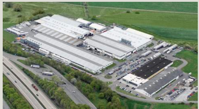
Sede centrale UNILUX a Salmtal
