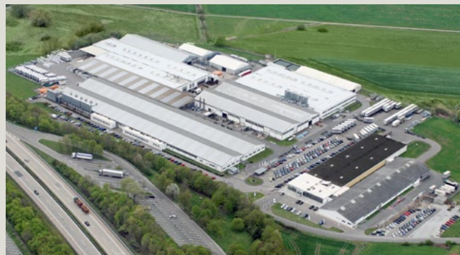
Sede centrale UNILUX a Salmtal
